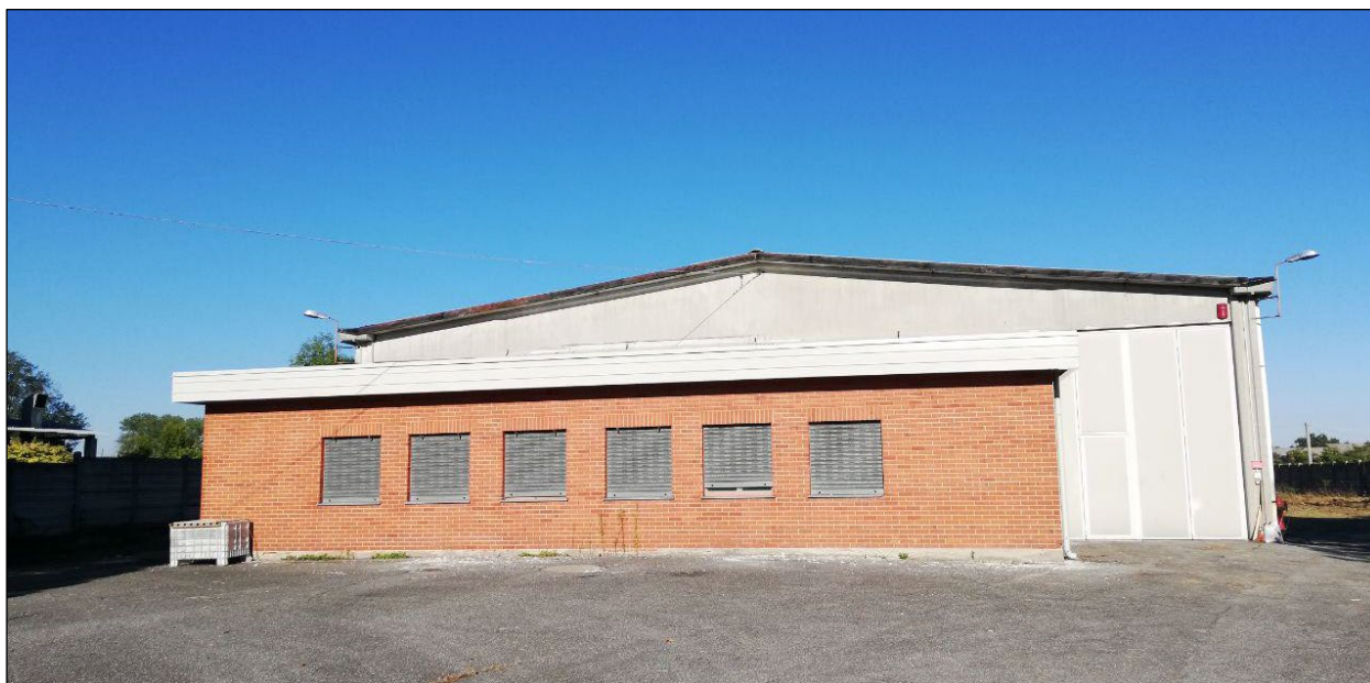
Figura 9: Foto del capannone industriale in esame - vista piazzale lato via XX Settembre.
