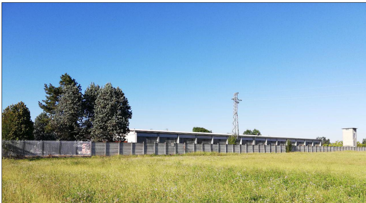
Figura 10: Foto del capannone industriale in esame - vista lato sud.
