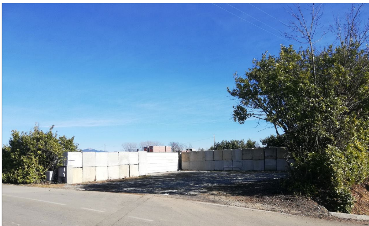
Figura 12: Foto del sito in esame - vista lato ovest.
