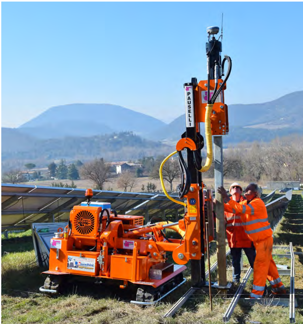
Figura 32 Particolari macchinario infissione pali nel terreno
