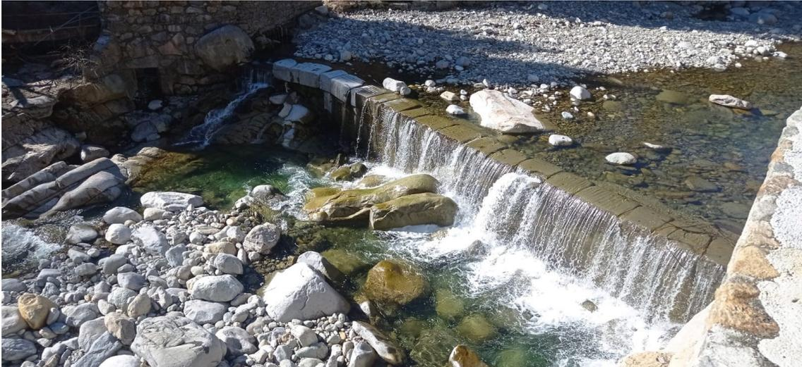
La derivazione e il canale di scarico si sviluppano in destra idraulica. Durante gli eventi alluvionali del mese di Ottobre 2020, le opere sono state coinvolte dagli eventi di piena (con trasporto solido rilevante, costituito in prevalenza da ciottoli e blocchi) e rese inutilizzabili.
