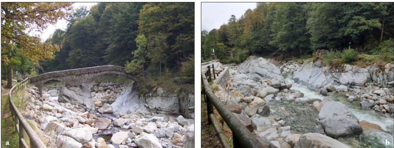
Figura 238. Piedicavallo, il ponte pedonale della Coda: a) prima e b) dopo il passaggio della piena del Cervo.
