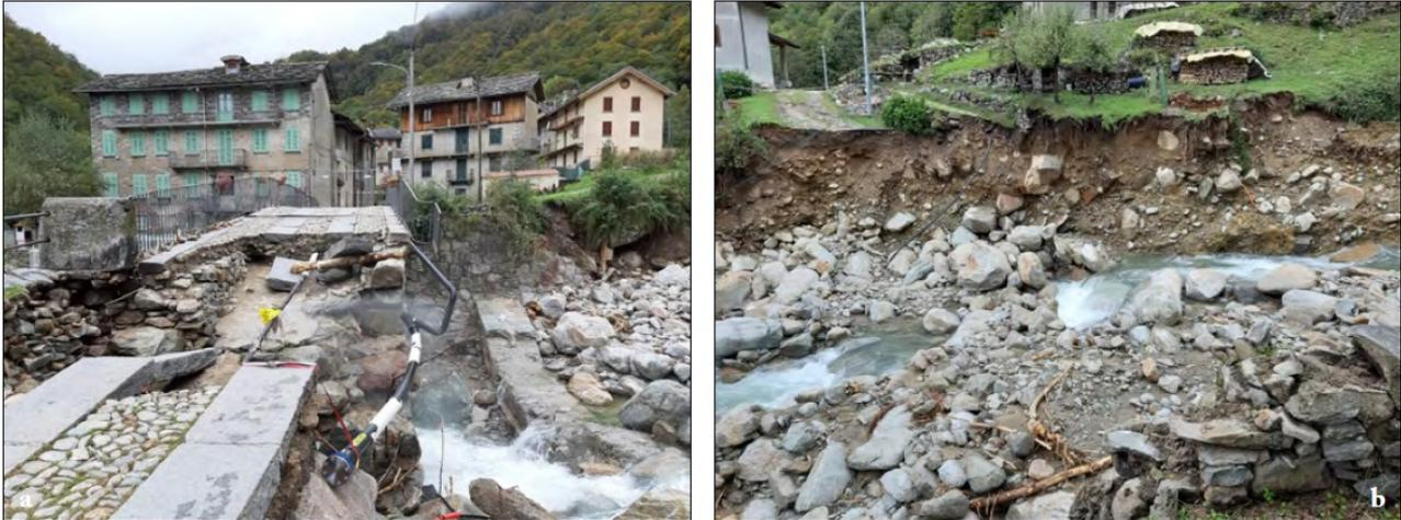
Figura 237. Piedicavallo, Torrente Mologna: a) danni al ponte della strada antica; b) erosione spondale in corrispondenza della passerella pedonale distrutta.
