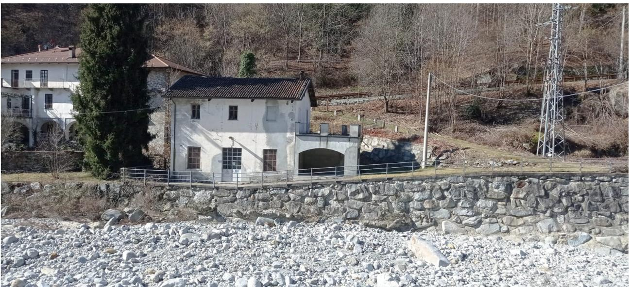
L'edificio si sviluppa a quote superiori rispetto al fondo alveo, nel tratto in cui la sponda è protetta da un muro rivestito in pietrame. Le fondazioni dell'edificio sono impostate (molto probabilmente) su terreni alluvionali che, con spessore non superiore a 2.0 m, sono presenti sopra il substrato roccioso alla base del versante destro.
