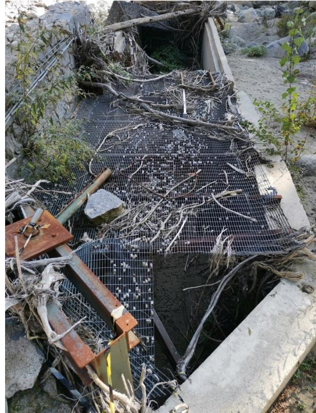
*Vasca dissabbiatrice da svuotare e grigliato di calpestio da sostituire con solaio a lastre*
