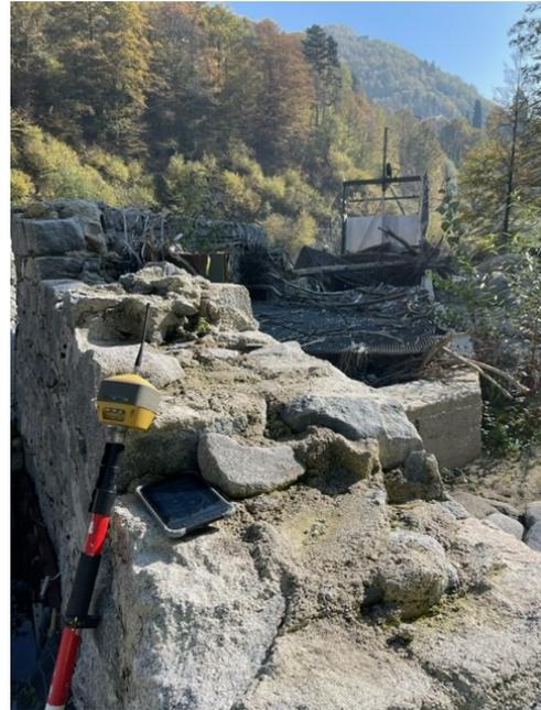
*Muro d'ala da traslare sul confine di proprietà per ampliare la sezione idraulica*
