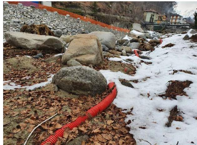
*Cavidotto da interrare con verifica della continuità dei conduttori.*
