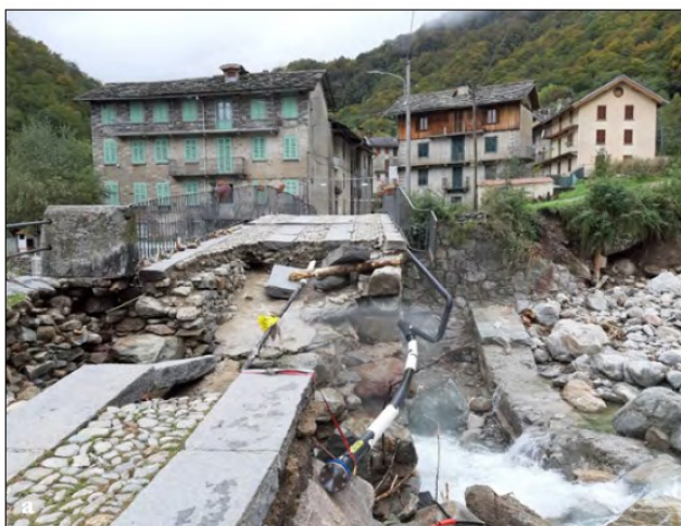
Figura 237. Piedicavallo, Torrente Mologna: a) danni al ponte della strada antica; b) erosione spondale in corrispondenza della passerella pedonale distrutta.
