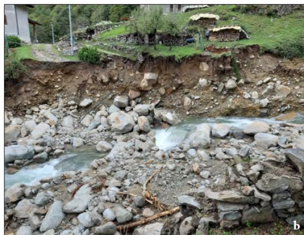
Figura 237. Piedicavallo, Torrente Mologna: a) danni al ponte della strada antica; b) erosione spondale in corrispondenza della passerella pedonale distrutta.
