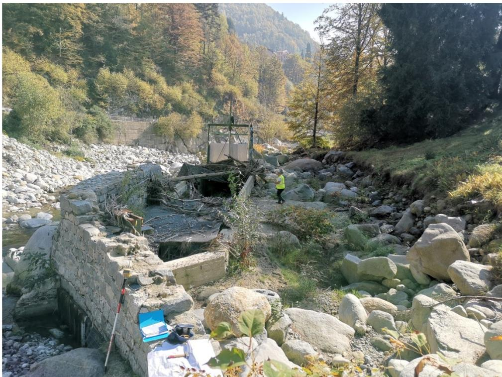
*Foto 8-9: Vasca dissabbiatrice da svuotare e da coprire con solaio a lastre*
