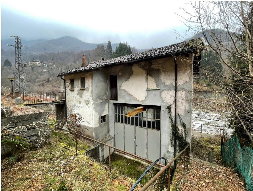
*Foto 20-21: Porzione di torrente antistante il fabbricato centrale da sgaiare per liberare il canale di scarico della centrale*
