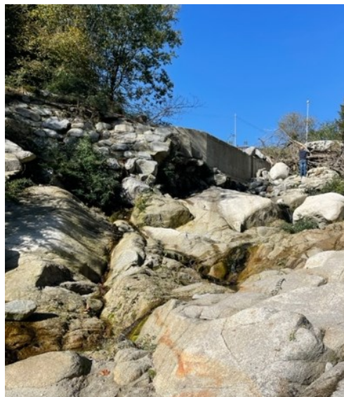
Porzione di canale sul mappale 597 del foglio 7 del NCT di Campiglia Cervo da proteggere con sottomurazione intasata di calcestruzzo
