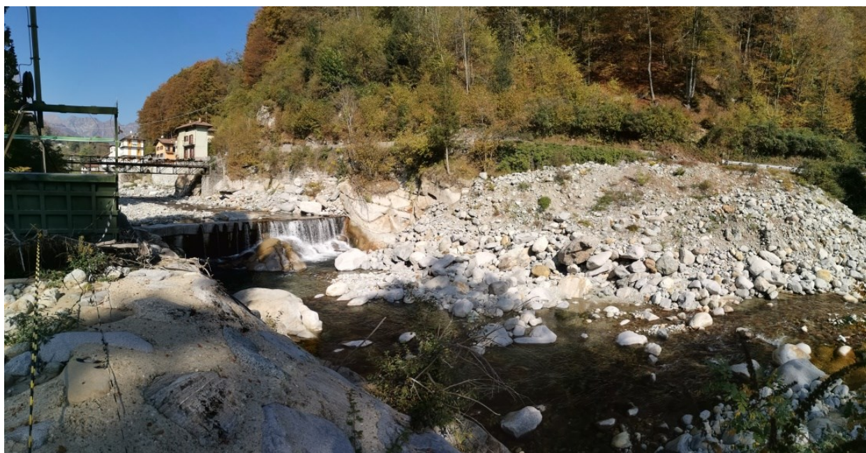
Deposito in sponda sinistra ove realizzare la pista di accesso temporanea
