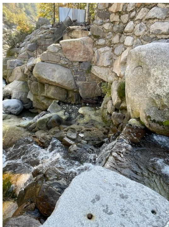
Scala dei pesci da eliminare e sostituire con nuova scala ai sensi della D.G.R. 13 luglio 2015, n°25-1741 "Approvazione delle "Linee guida tecniche per la progettazione e il monitoraggio dei passaggi per la libera circolazione della fauna ittica"
