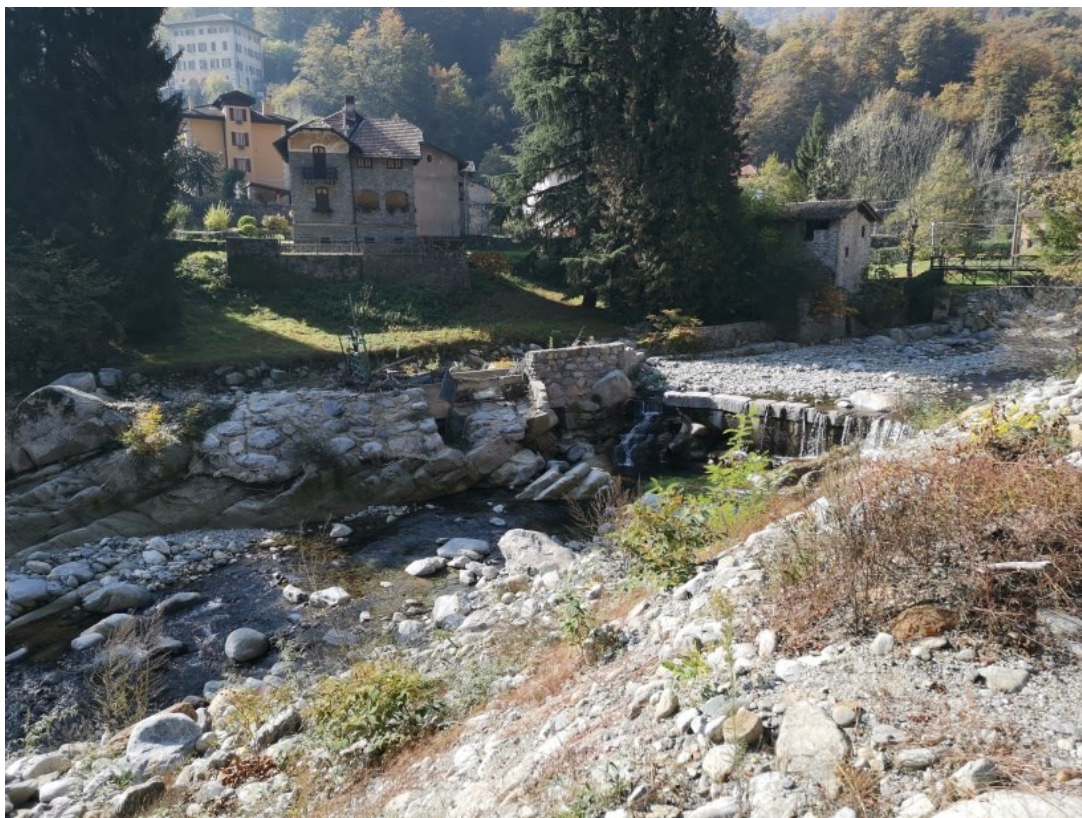
Vista d'insieme dell'opera di presa.
