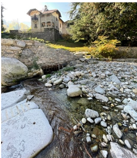
Finestra di captazione da sostituire con nuova griglia Coanda.
