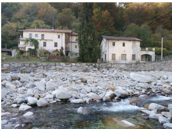
Zona inghiaia del canale di scarico
