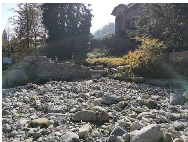
Muro d'ala da traslare sul confine di proprietà per ampliare la sezione idraulica
