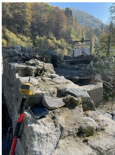
Muro d'ala da traslare sul confine di proprietà per ampliare la sezione idraulica
