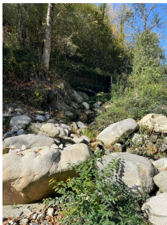
Porzione di canale sul mappale 597 del foglio 7 del NCT di Campiglia Cervo da riparare e proteggere ricoprire con sottomurazione intasata di calcestruzzo
