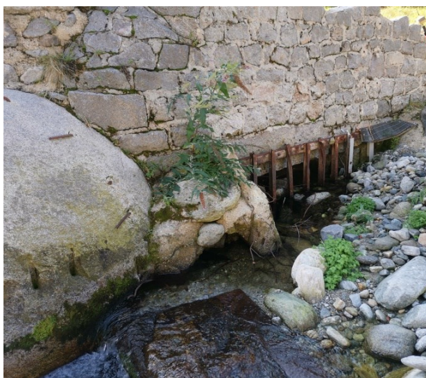
Finestra di captazione da sostituire con nuova griglia Coanda.
