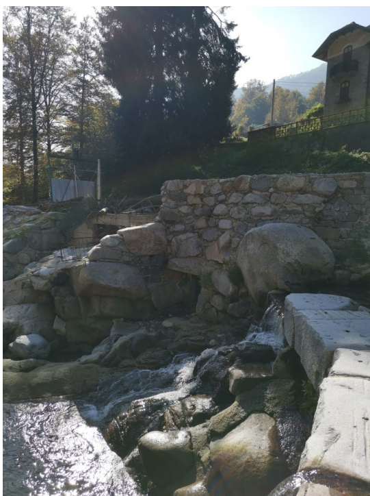
Scala dei pesci da eliminare e sostituire con nuova scala ai sensi della D.G.R. 13 luglio 2015, n°25-1741 "Approvazione delle "Linee guida tecniche per la progettazione e il monitoraggio dei passaggi per la libera circolazione della fauna ittica"
