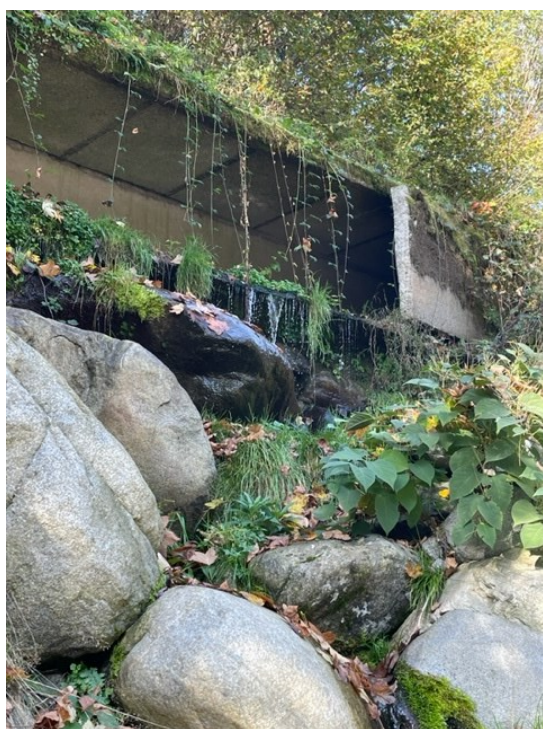
Porzione di canale sul mappale 597 del foglio 7 del NCT di Campiglia Cervo da riparare e proteggere ricoprire con sottomurazione intasata di calcestruzzo
