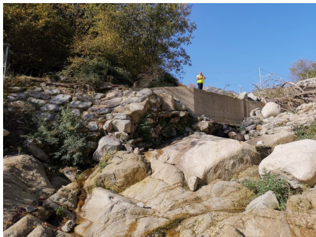
Porzione di canale sul mappale 597 del foglio 7 del NCT di Campiglia Cervo da proteggere con sottomurazione intasata di calcestruzzo
