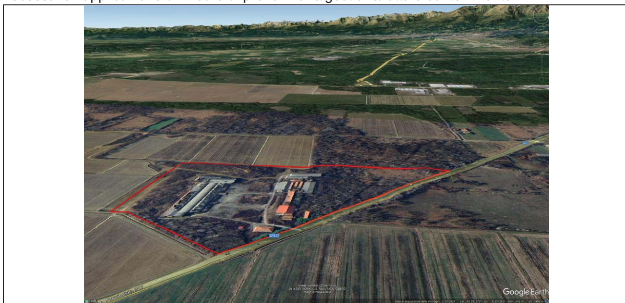
Figura 18 Vista a volo d'uccello del sito
