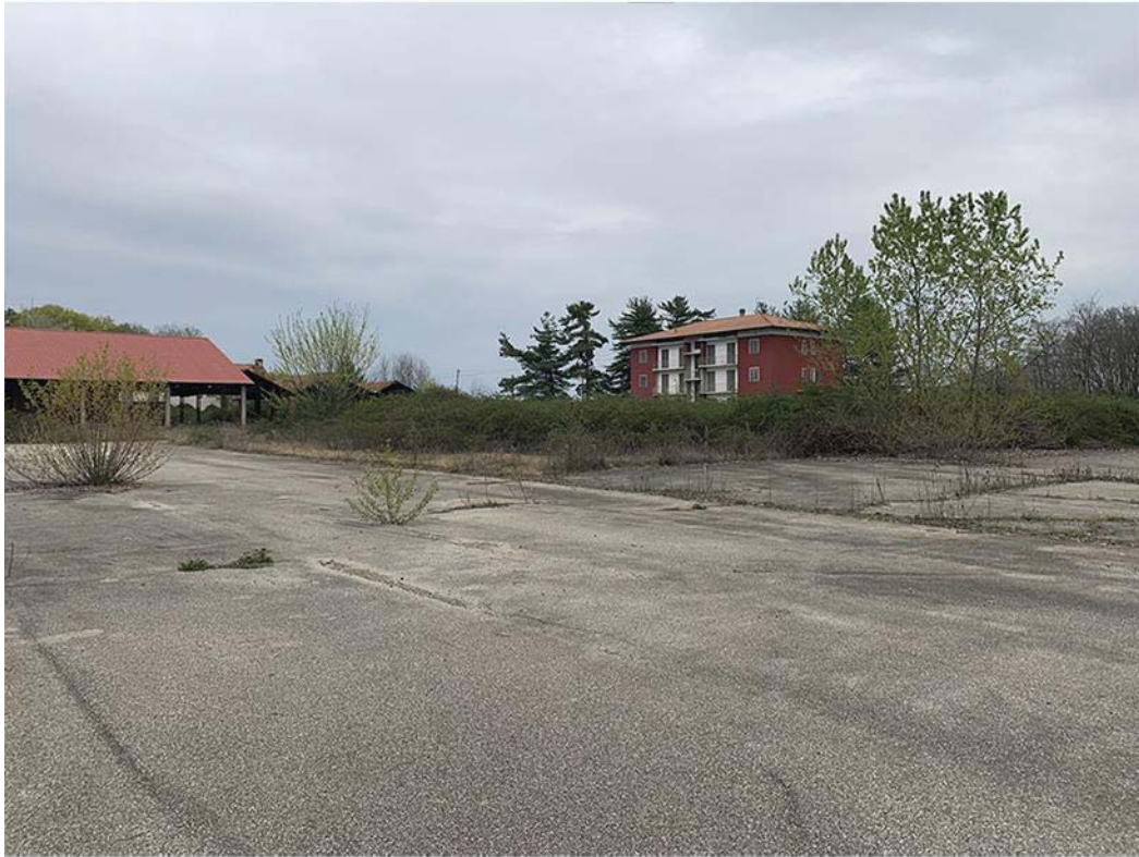
Figura 14 Foto f2 – Piazzale interno tra i fabbricati – sul fondo edificio residenziale e a sinistra fornace
