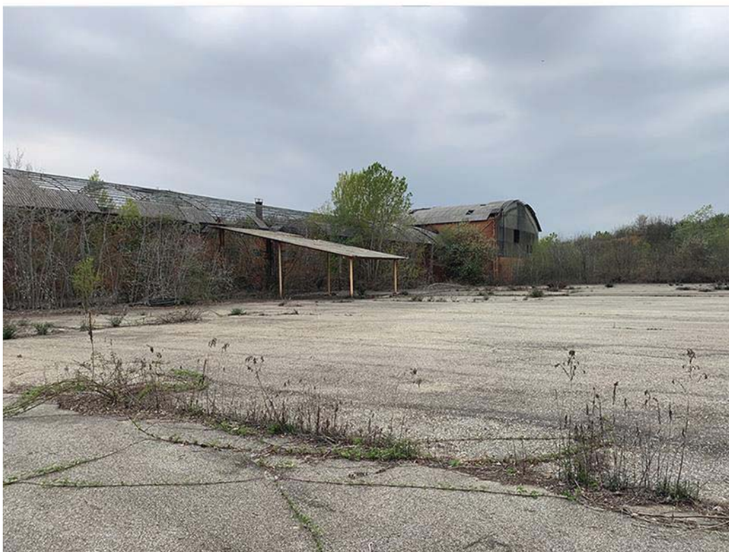
Figura 15 Foto f3 – Piazzale interno tra i fabbricati – capannone di stoccaggio
