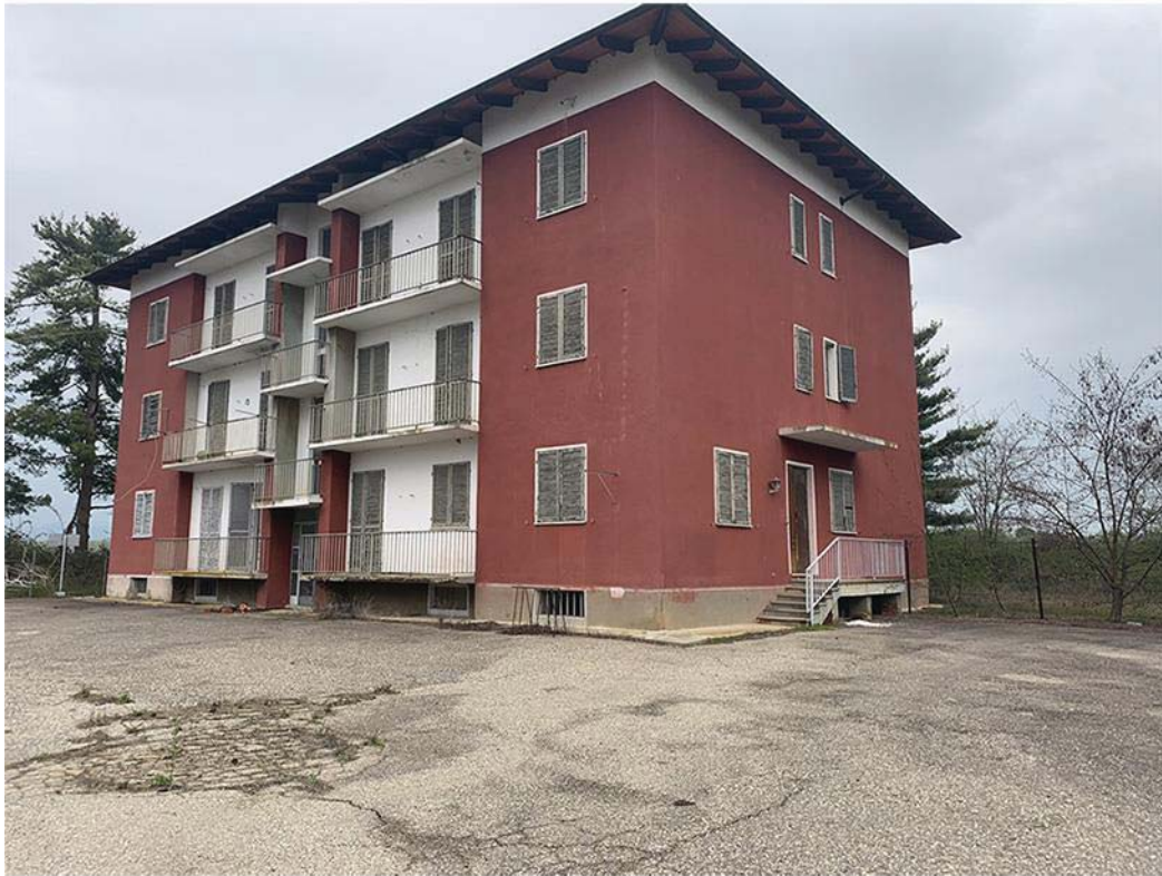
Figura 13 Foto f1 – Edificio residenziale posto in prossimità ingresso al lotto
