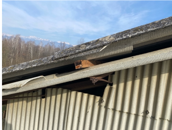
tettoia doppia del capannone 3.
