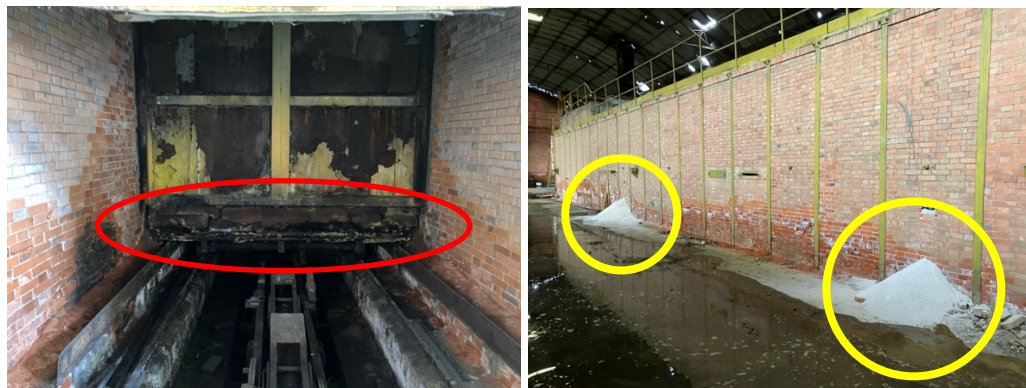
carrello forno muro del forno con contenuto dell'intercapedine
