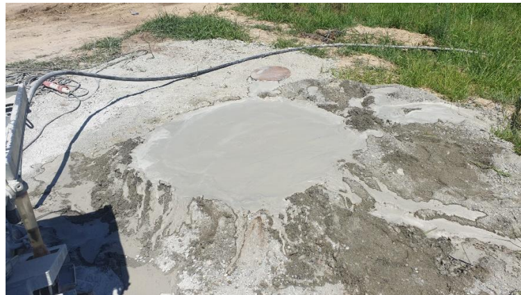
Figura 3 – Cementazione eseguita fino al piano campagna.
