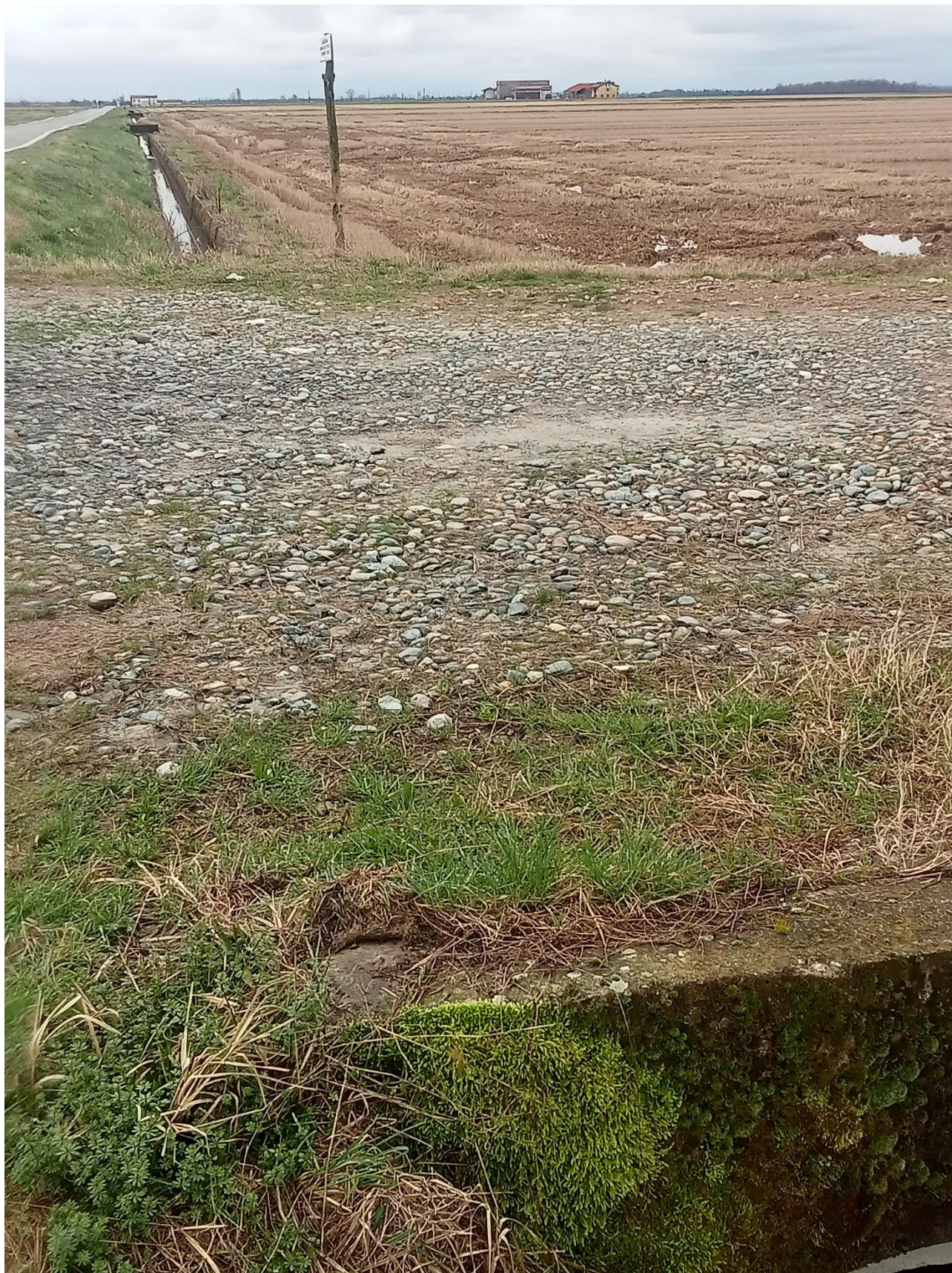
Foto n. 4 vecchio accesso strada poderale da mantellare
