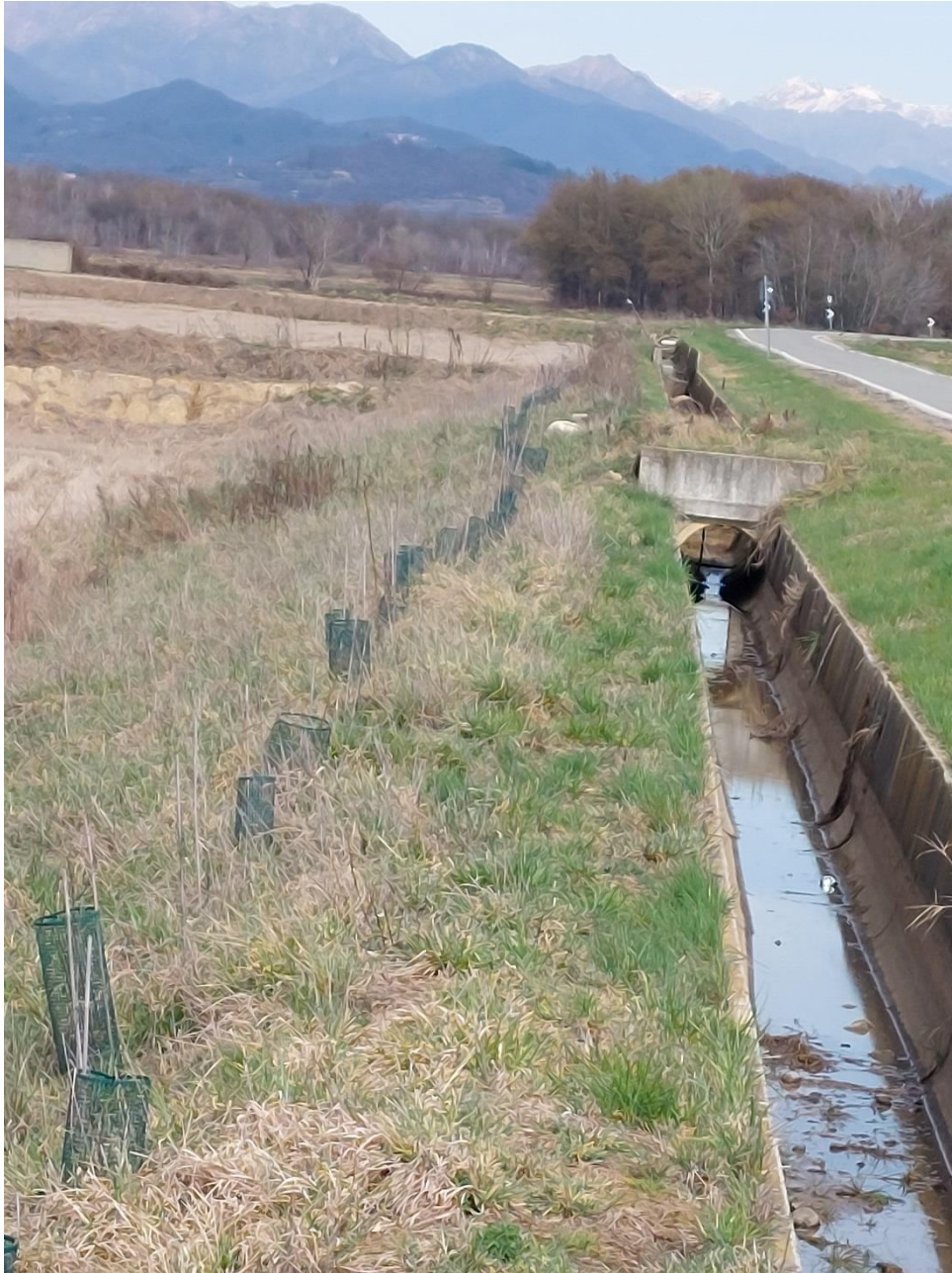
PIANA C: Filare arbustivo piantumato con shelter di protezione ed inerbimento della scarpata di nuova formazione posta ad est della camera di risaia "C" vista da SUD con presenza fosso irriguo che corre a fianco della Sp. adiacente alla S.P. 316 "Strada Buronzina".
