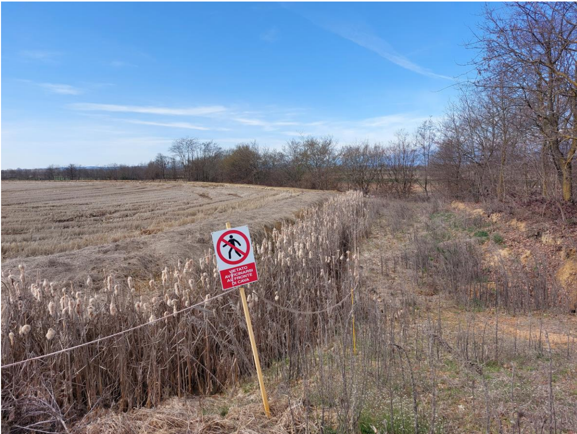
FOSSO FITODEPURAZIONE: Buon sviluppo della vegetazione eliofita (tratto terminale )
