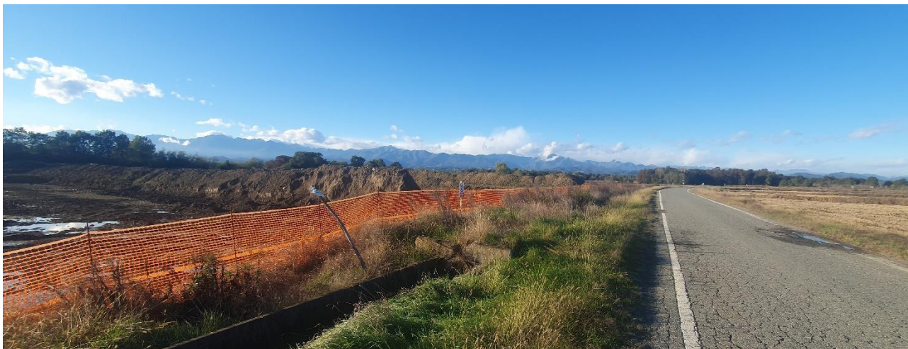
Figura 5 – Vista ripresa dalla strada SP316 da S verso N in cui è visibile il fosso colatore costituito da canaletta in cemento, la recinzione con rete da cantiere. La rete è posta dopo il fosso colatore di proprietà del Consorzio di Bonifica della Baraggia per consentire agli addetti l'ispezione e la manutenzione.
