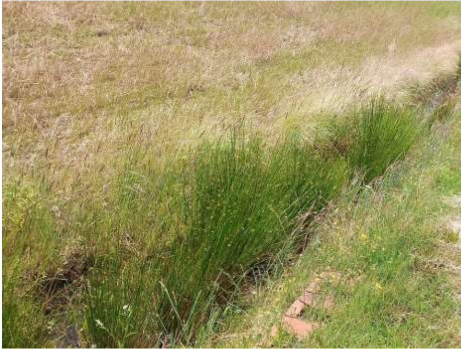
Figura 13 -. Fosso di scolo esterno all'area di intervento (lato W) con presenza di specie palustri con funzione di canale fitodepuratore.
