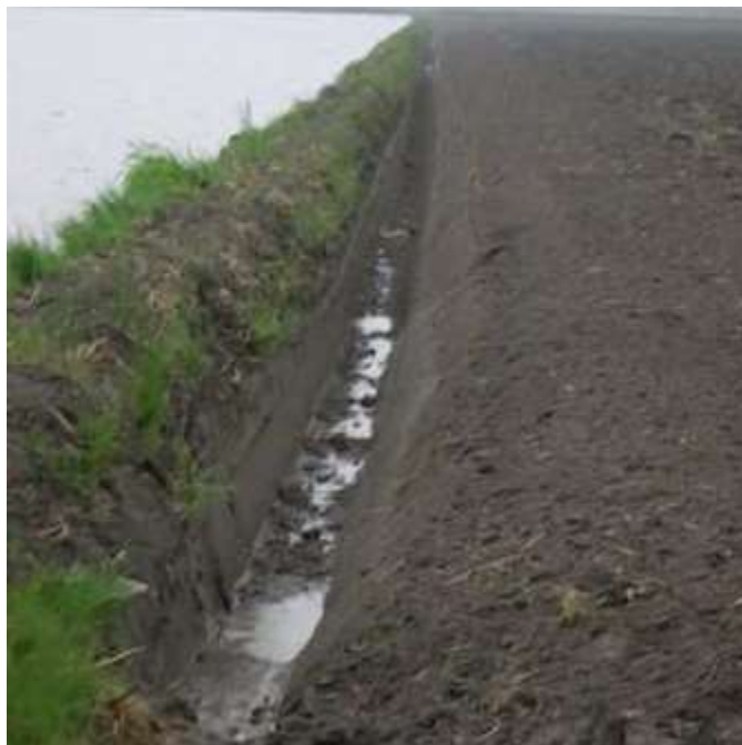
Figura 14 -. Costruzione fosso a bordo camera risaia con funzione di riserva d'acqua durante l'asciutta
