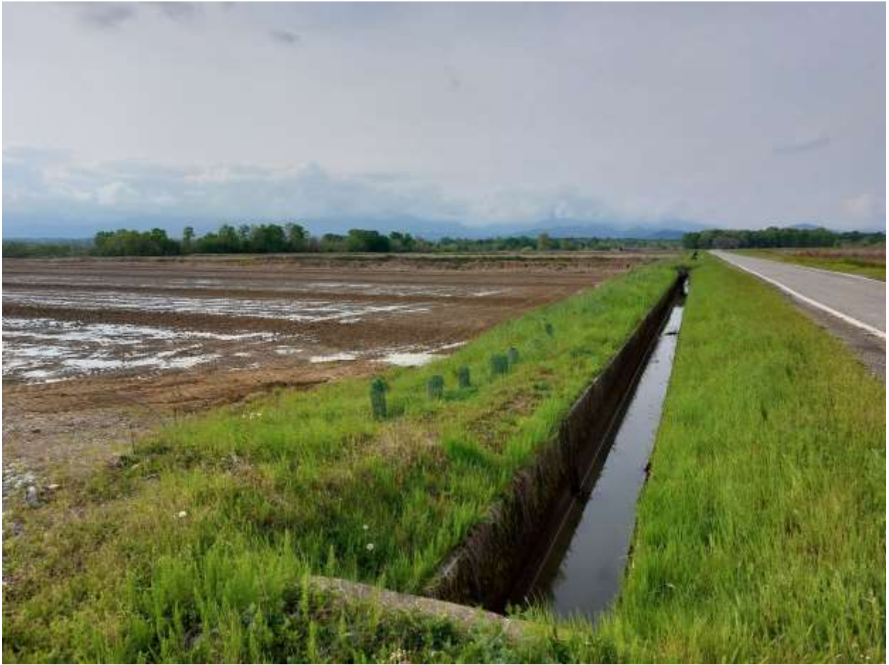
Figura 21 – area di lavoro a fine intervento con l'impianto del filare arboreo-arbustivo per la costituzione del corridoio ecologico
