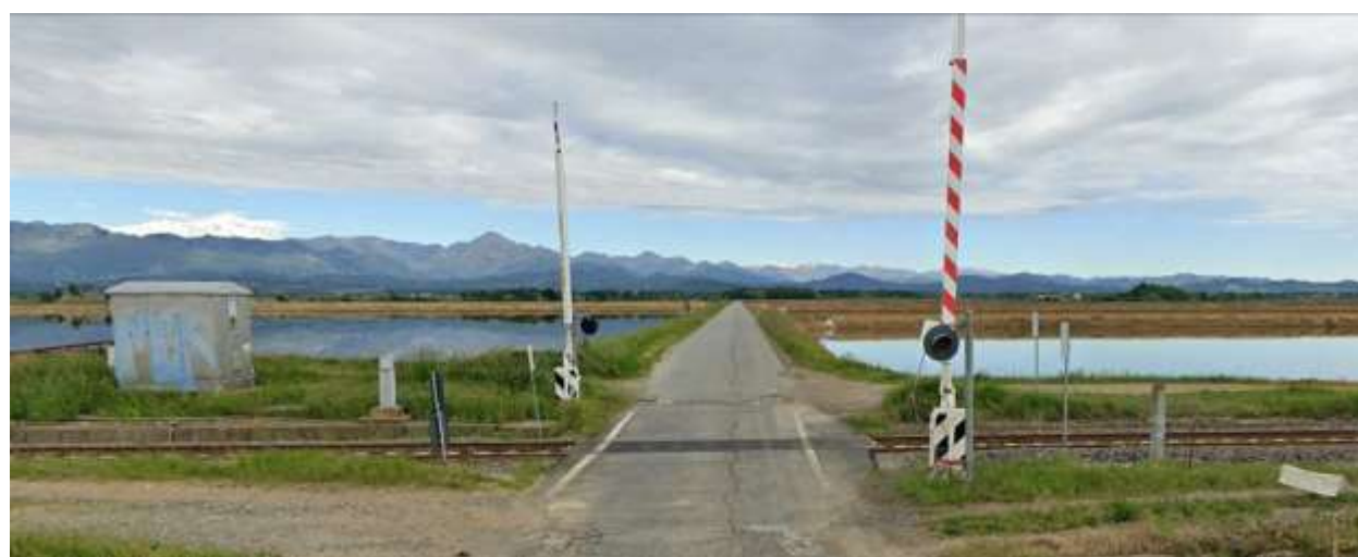
Figura 62 - Foto vista da Sud (passaggio a Livello Linea FFSS BI-NO) dell'area di lavoro
