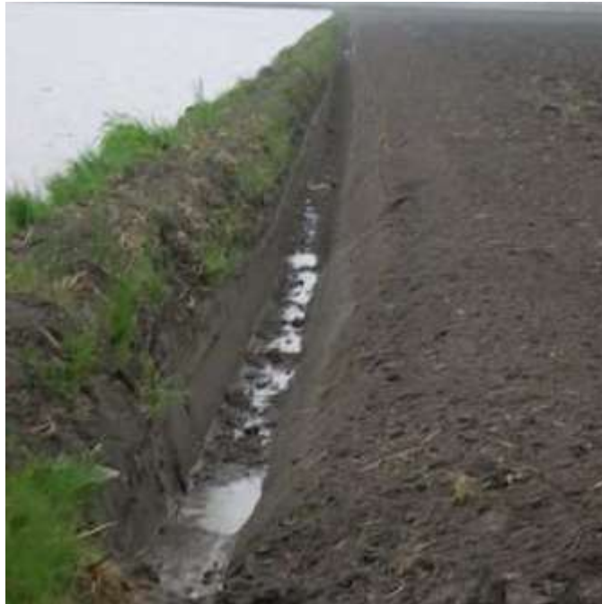
Figura 57 -. Costruzione fosso a bordo camera risaia con funzione di riserva d'acqua durante l'asciutta
