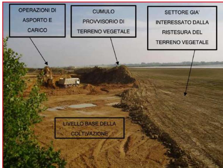
Fig. 4 - Modello delle fasi dei lavori (da relazione di progetto)
